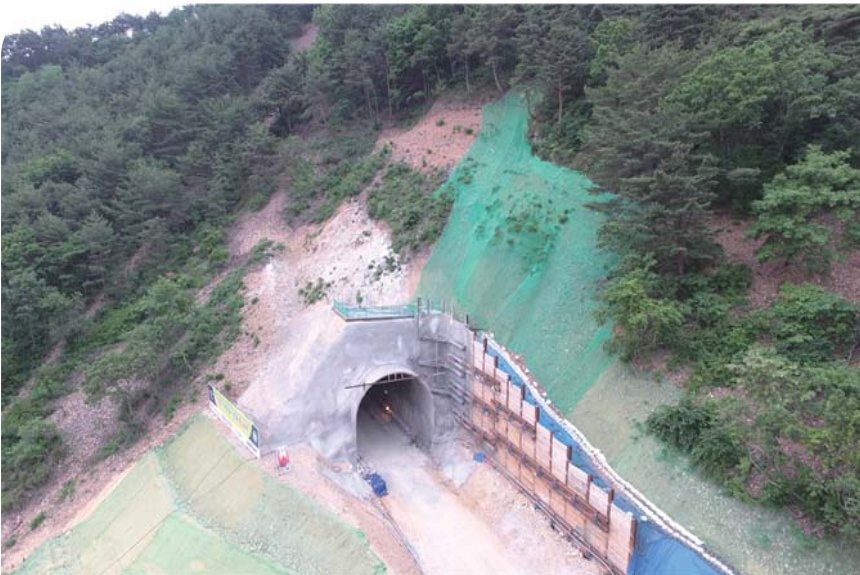
테일러스층 사면에 갱구부 형성 전경 (터널연장 및 고화토 성토로 환경훼손 최소화)
