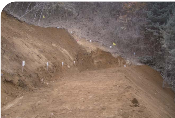
터널계획면 상부 원지반 굴착
