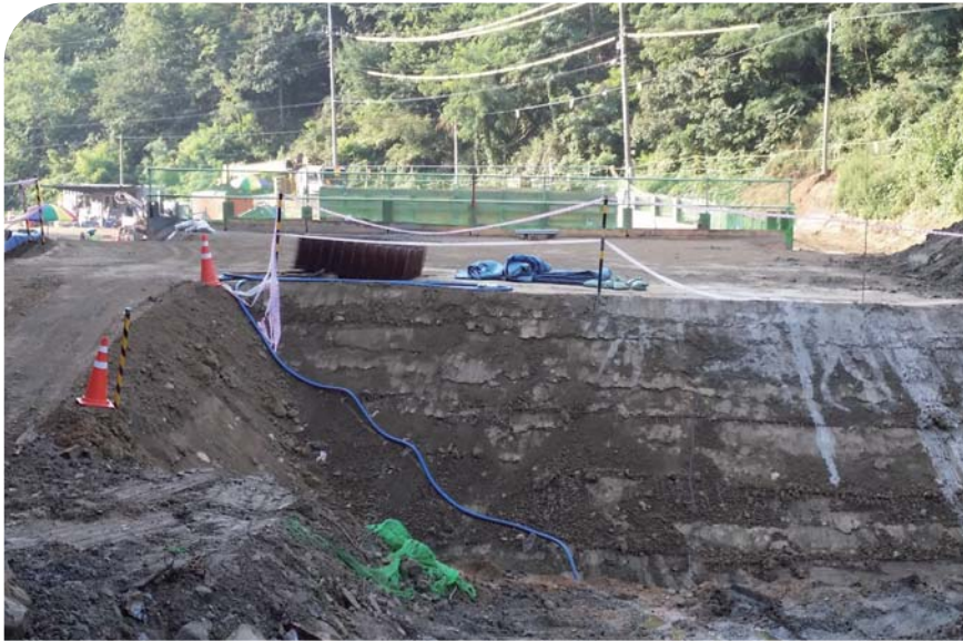
고화토 처리 전경
