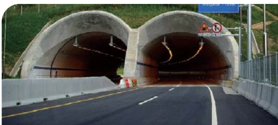
1-Arch 선지보 대단면 터널 적용시 구조적 안정 유리, 전기시설등 내부 시설물 감소 및 운전자 시야감 확보
