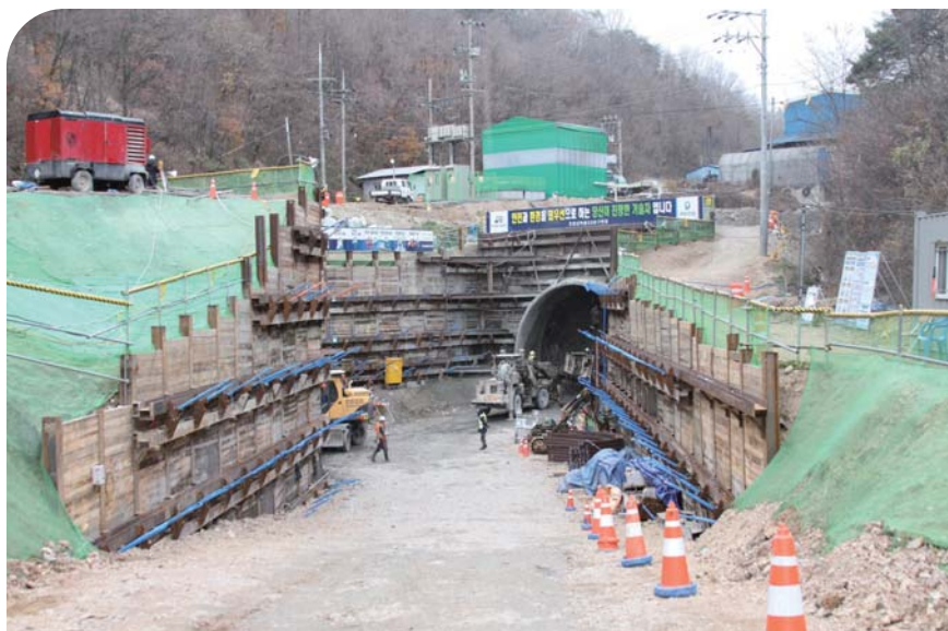
개착구간 가시설 전경
