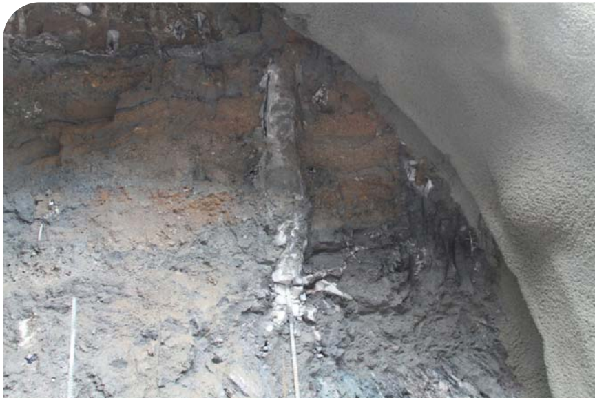
굴착 중 막장 관찰 (연약지반 선지보네일 그라우팅 구간 확인)
