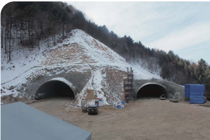
시공완료 후 갱구부 전경 (갱구부:터널시공, 갱구후사면 중간부:고화토 + 갱외선지보)
