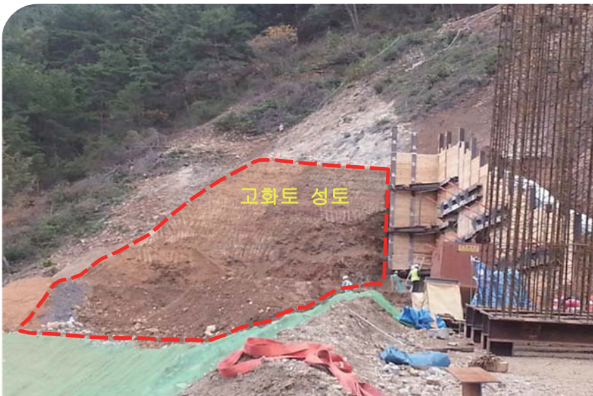
고화토 성토 완료 (편측 고화토 성토 후 수직으로 절취)
