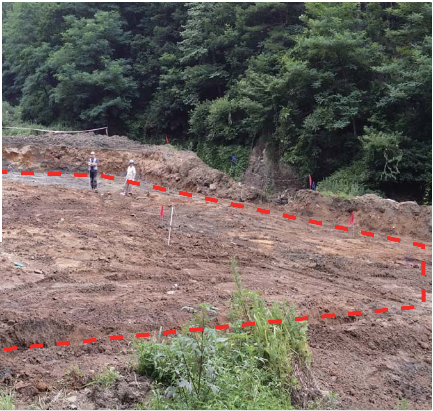
시공 전 벌개제근 후 전경
