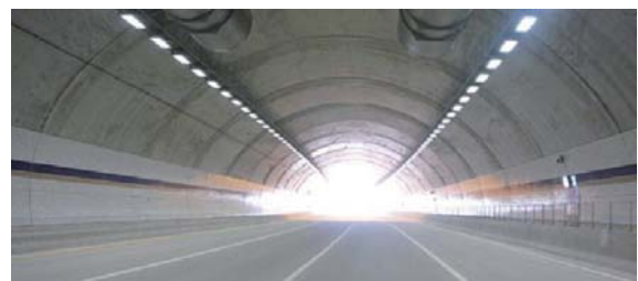
1-Arch 선지보 대단면 터널 적용시 구조적 안정 유리, 전기시설등 내부 시설물 감소 및 운전자 시야감 확보
