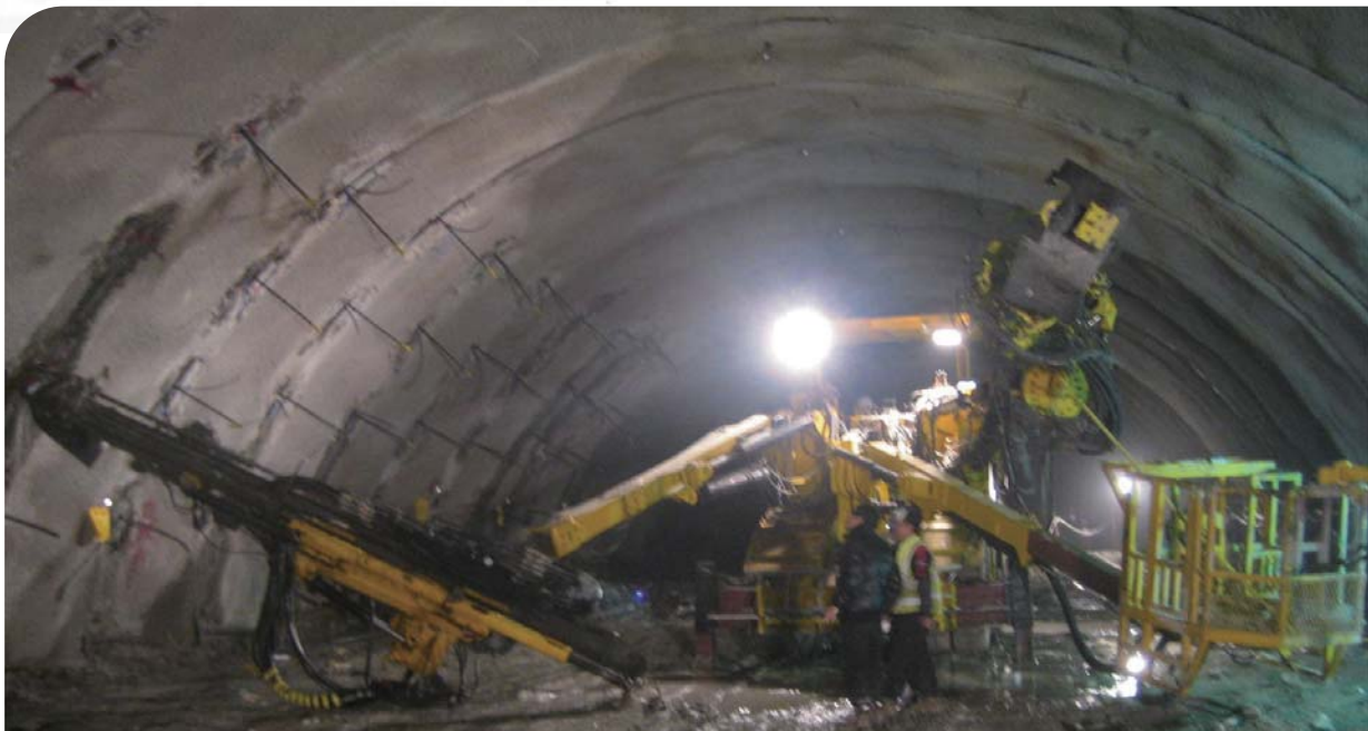
선지보 전용장비를 이용한 궤내천공
